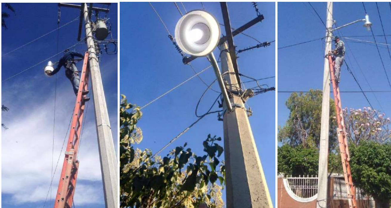
En las canchas de El Terrero y Tazumbos, se ha colocado nuevo equipo de lámparas led de 150 watts y en otras localidades, se ha incrementado el alumbrado público con la instalación de un total de 30 luminarias, en algunas de ellas no se contaba con alumbrado público desde hace cuatro años.
